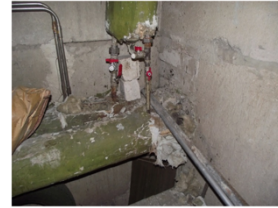
Algirdo g. 25, Vilnius. Šildymo stovas rūsyje. Reguluojamosios armatūros nėra, todėl balansavimas neįmanomas. Stovas rakinamame sandėliuke.
