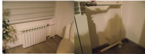
Algirdo g. 25, Vilnius. Vienvaizdė šildymo sistema. Radiatorius turi tik uždaromąją armatūrą, termostatas neįrengtas. Nuo senų laikų palikęs tricreis ventilius, kurį bandyti judinti rizikinga.
