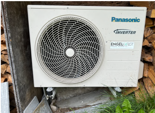
Abbildung 61: Bergrestaurant Spalegna mit Klimaanlage zum Heizen
