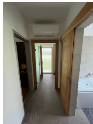
Abbildung 47: Inneneinheit (Wandgerät) im Flur bei den Schlafzimmern
