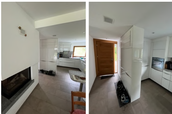
Abbildung 46: Inneneinheit nahe dem Hauseingang, welches kaum sichtbar in das Küchenmöbel integriert wurde
