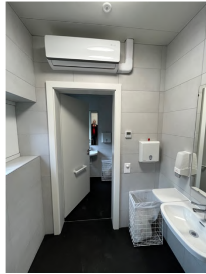
Abbildung 39: Inneneinheit D17 (2.2 kW Heizleistung) in Toilettenräumen
