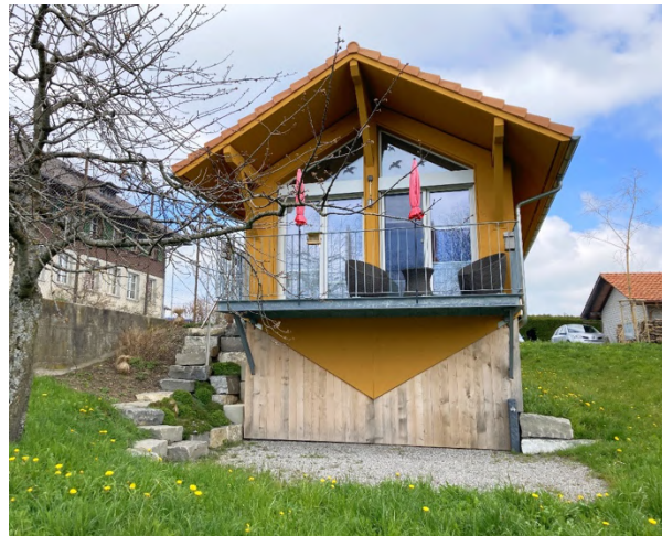
Abbildung 19: Durch die Hanglage ergibt sich ein Hohlraum unter dem Erdgeschoss, der als Bodenheizung fungiert.
