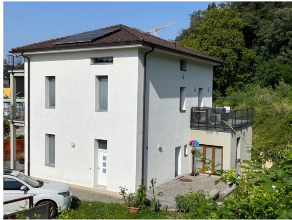
Abbildung 53: Anbringung des Aussenteils auf der Terrasse im 1. Stock in Richtung Nord-Osten
