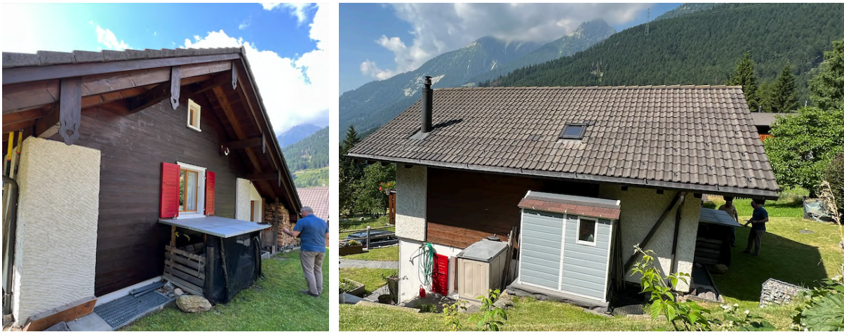
Abbildung 68: Mögliche Standorte für Aussenteile der Klimaanlage
