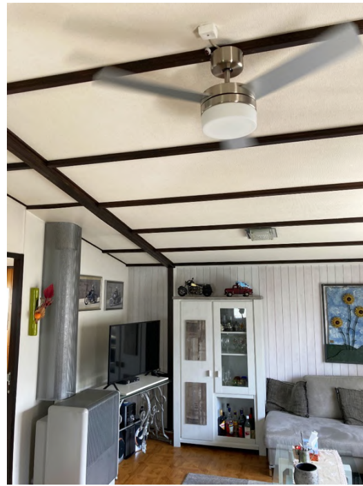
Abbildung 30: Der Deckenventilator sorgt für bessere Wärmeverteilung im Raum.
