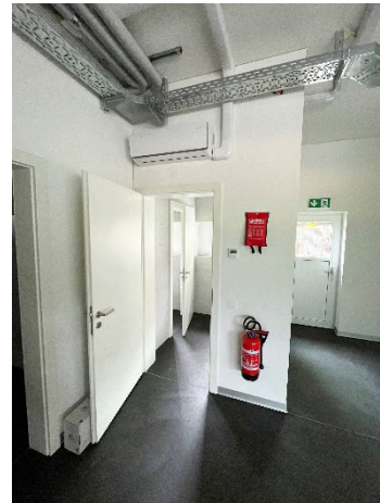
Abbildung 39: Inneneinheit D17 (2.2 kW Heizleistung) in Toilettenräumen
