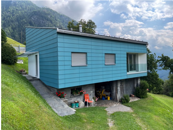
Abbildung 42: Aussenansicht der Süd- u. Westfassade. Nur das Erdgeschoss - das obere Stockwerk - ist beheizt.
