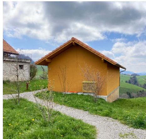
Abbildung 21: Das Aussenteil befindet sich an der Hausrückseite und ist mit Holz verkleidet.
