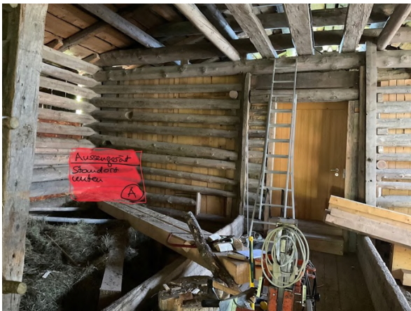
Abbildung 77: Aussenteil in gut durchlüftetem Lagerraum
