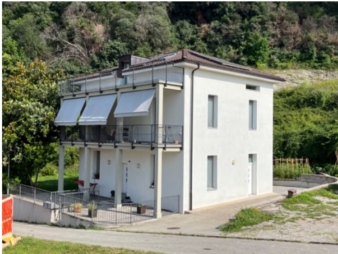
Abbildung 50: Gebäudeaussenansicht, Süd- und Ostfassade
